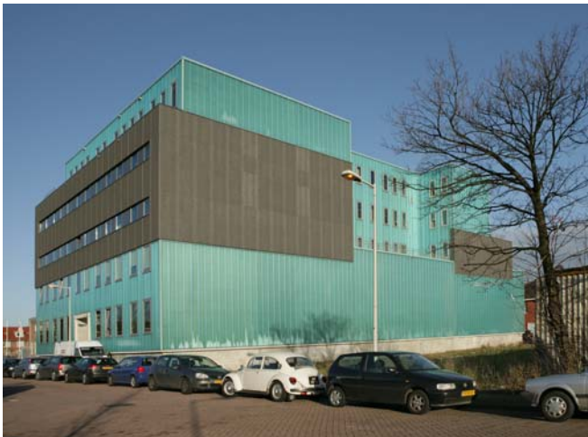
Bedrijfsverzamelgebouw Pand Noord II in Hamerstraatgebied
