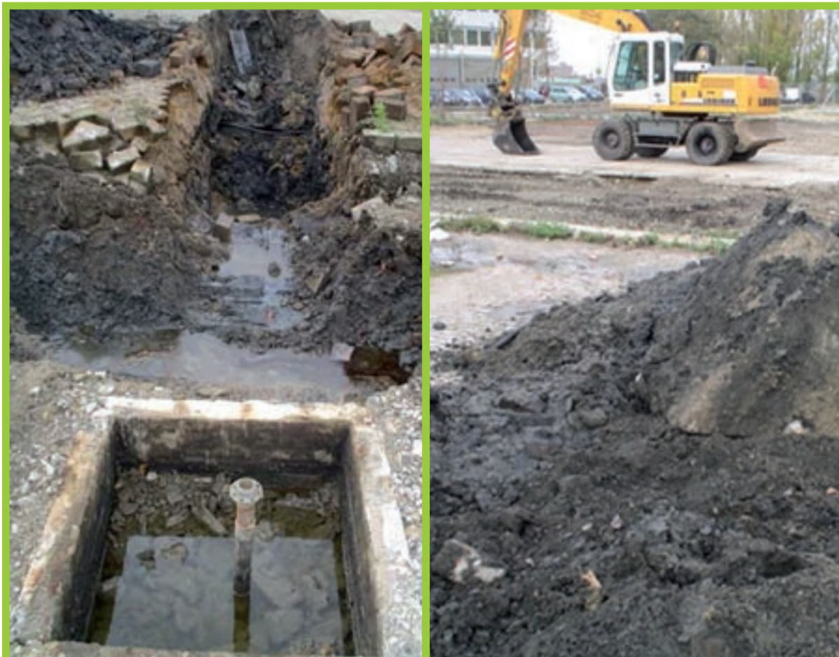
Achter het afleverpunt van een voormalige benzinepomp wordt een proefsleuf gegraven om te kijken of de mobiele verontreiniging daadwerkelijk op de plek zit waar verwacht wordt.
